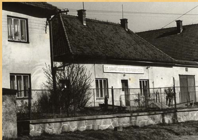
V roce 1953 se inseminační stanice přestěhovala do č.p. 80
